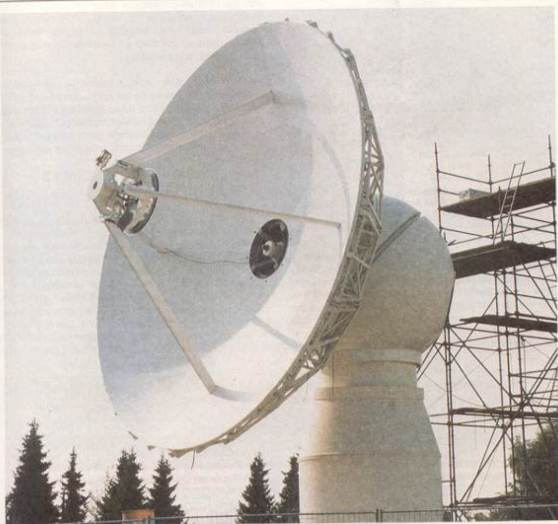
FOTO 1: Antena de la Estación ERS/VLBI Base O'Higgins, ya construida y siendo probada en Alemania (Gentileza Dr. Klemens Nottarp, IFAG/Alemania).
